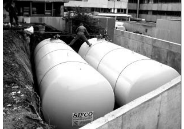
Chantier d'installation des nouvelles cuves de fuel
