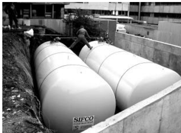
Chantier d'installation des nouvelles cuves de fuel
